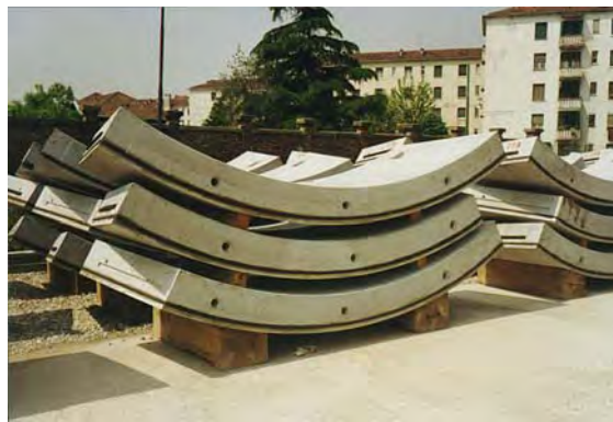
Abbildung 2-6 Lagerung von Tübbingen
